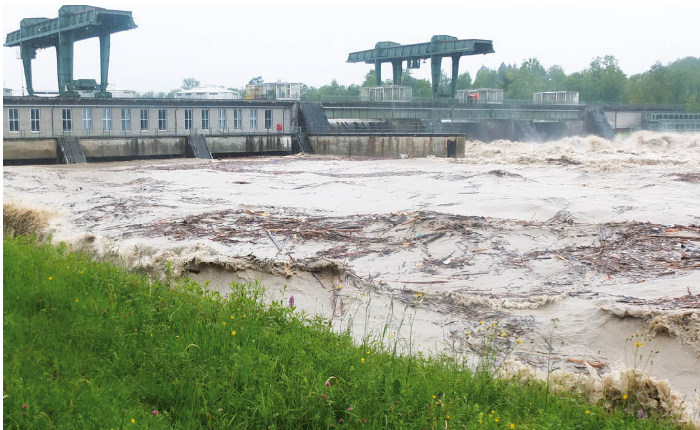
Die schweren Überschwemmungen der letzten Wochen haben auch die Gemeinde Rohrdorf nicht verschont. Die Inn-Staustufe bei Ziegelberg.
